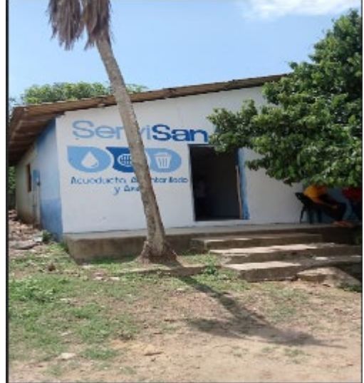
Foto 2 Oficina en Monterrubio
