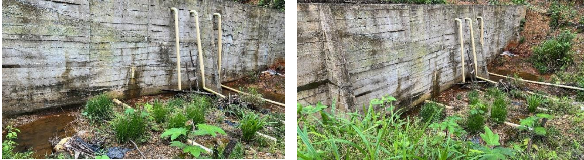
Aducción en la Quebrada La Tatabrera
