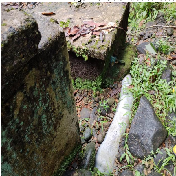
Conexión de desarenador a tanque
