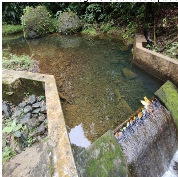
Sistema de captación
