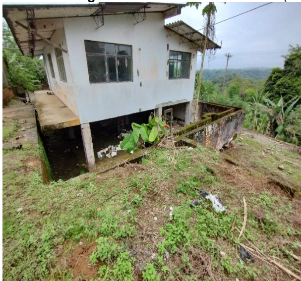
Sistema de Tratamiento en abandono
