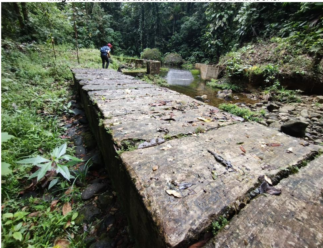
Imagen 10. Sistema de acueducto MUNICIPIO DE BARBACOAS.
