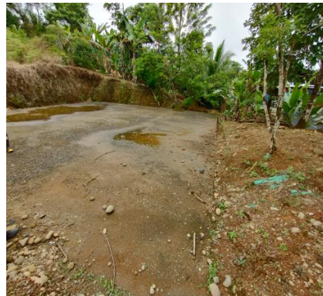
Tanque de almacenamiento
