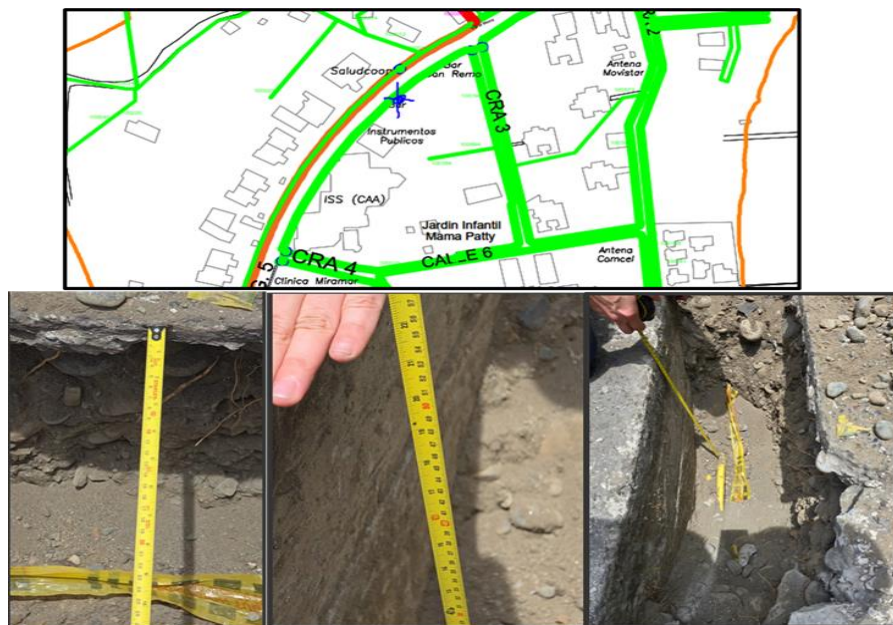
Imagen 3. Apique en red de distribución
