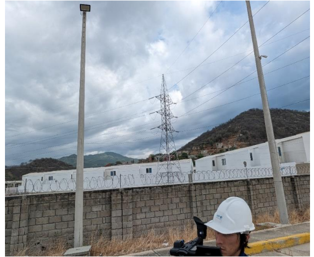
Torre de transmisión a nivel de 110 kV y proyecto de urbanización a las cercanías a esta torre.
