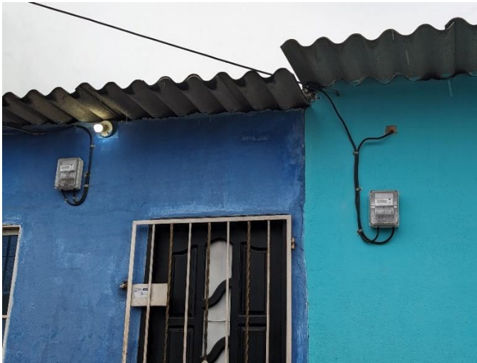
Displays instalados en las fachadas de los usuarios en los que se puede visualizar el consumo de facturado. Estos displays muestran la información registrada en los medidores ubicados a la altura de los postes.
