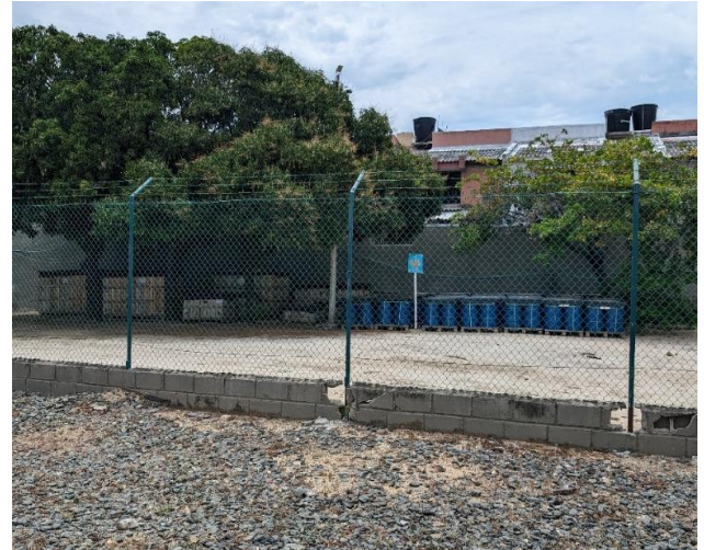
Patio para depósito de material.
