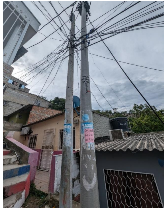
Postes de distribución y redes instalados para el proyecto.
