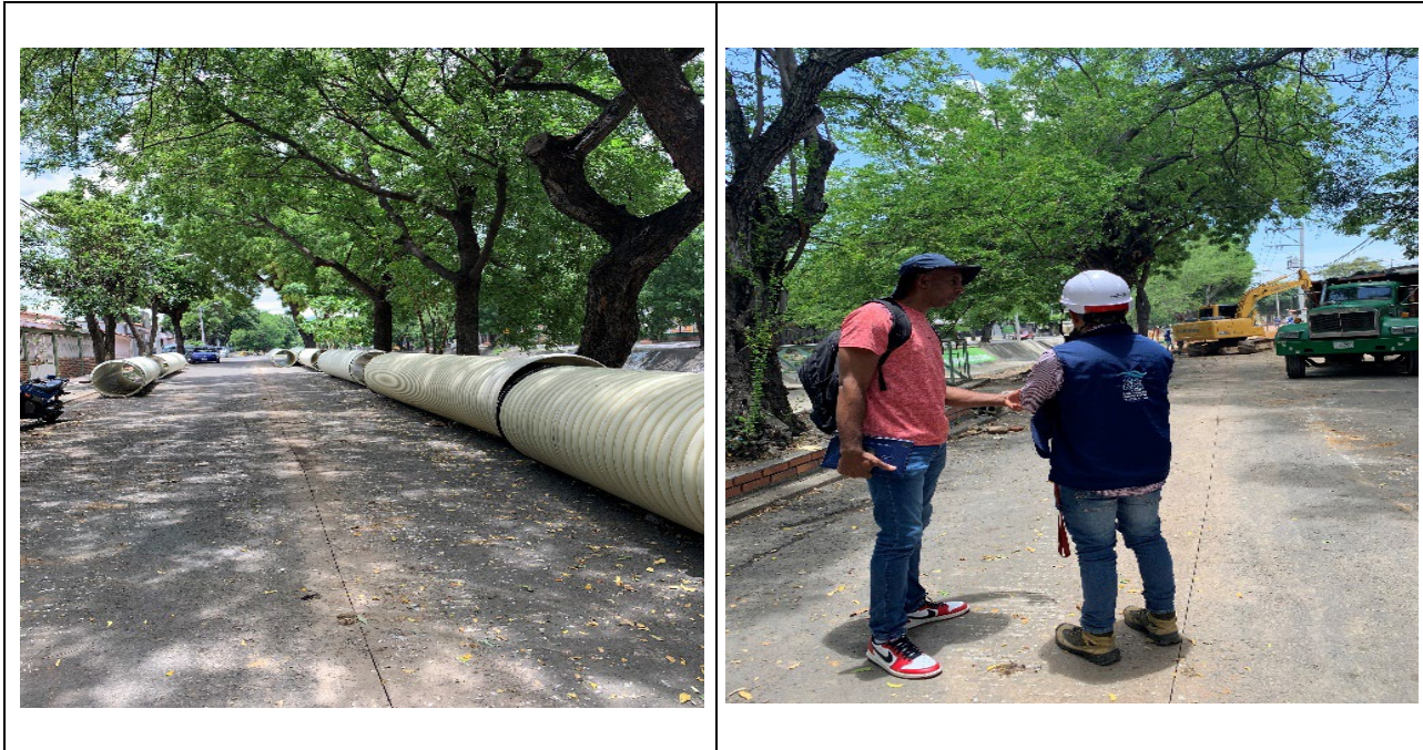
Imagen 11. Obra acueducto y alcantarillado Canal Bogotá
