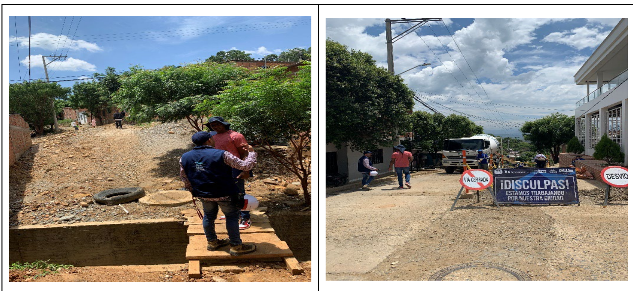
Imagen 13. Obra acueducto y alcantarillado Niña Ceci
