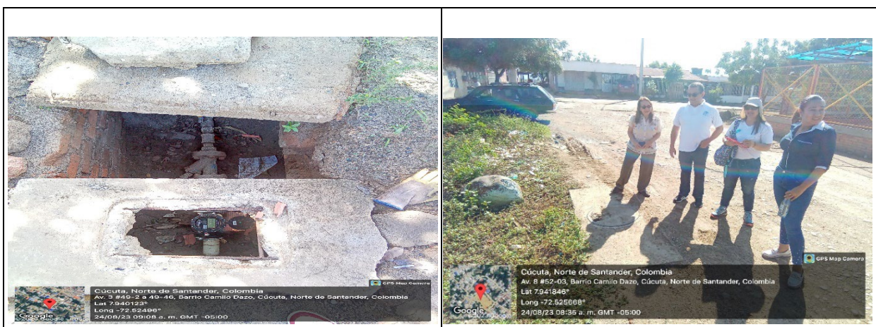
Imagen 7. Inspección pila pública funcionarios de la SSPD y Aguas Kpital S.A E.S. P
