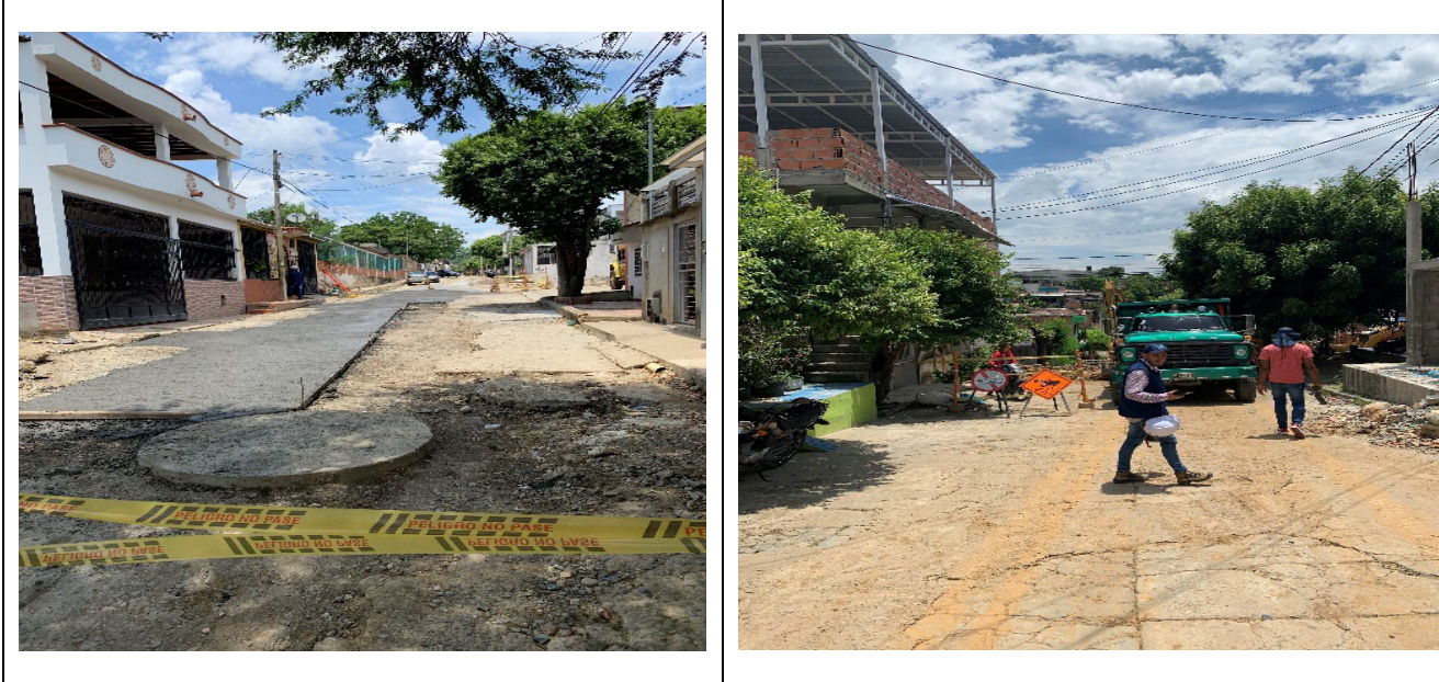
Imagen 12. Obra acueducto y alcantarillado Niña Ceci
