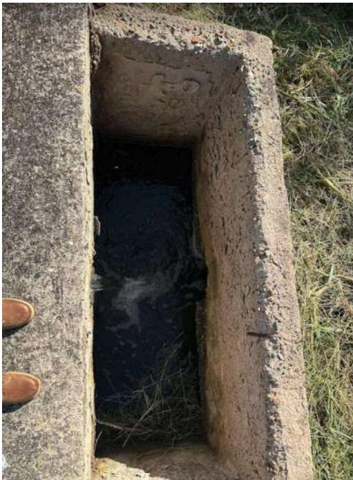
Canal de salida filtro Fafa e ingreso a tubería
