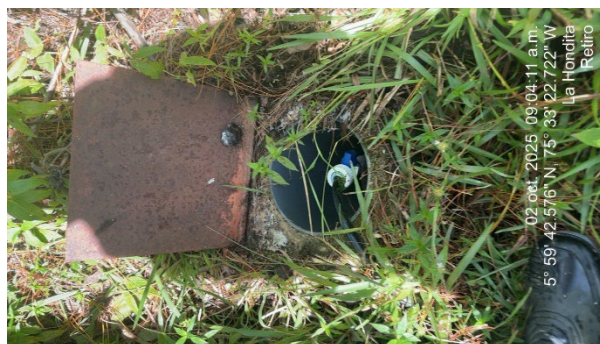
Imagen 11. Válvula ventosa presente sobre la línea de aducción
