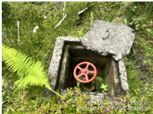
Imagen 10. Válvula de purga presente sobre la línea de aducción
