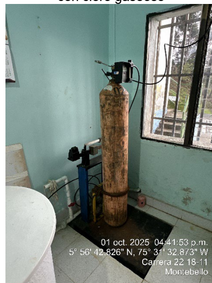
Imagen 17. Sistema de desinfección con cloro gaseoso
