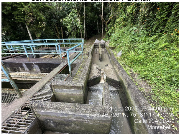
Imagen 26. Canal de entrada a la PTAR con su correspondiente canaleta Parshall
