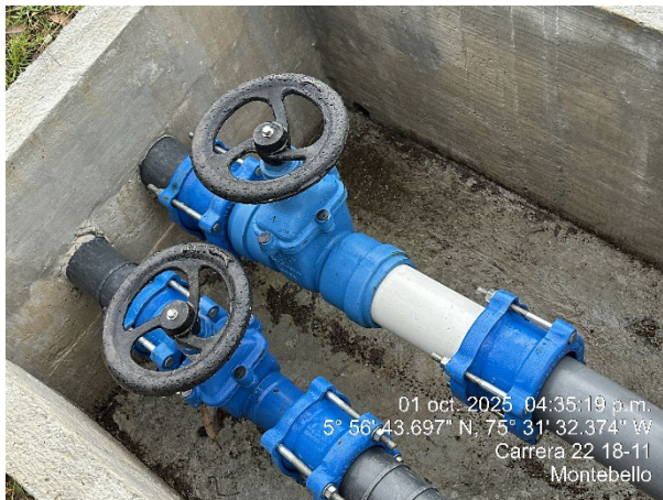
Imagen 22. Válvulas de cierre de los sectores hidráulicos del municipio de Montebello
