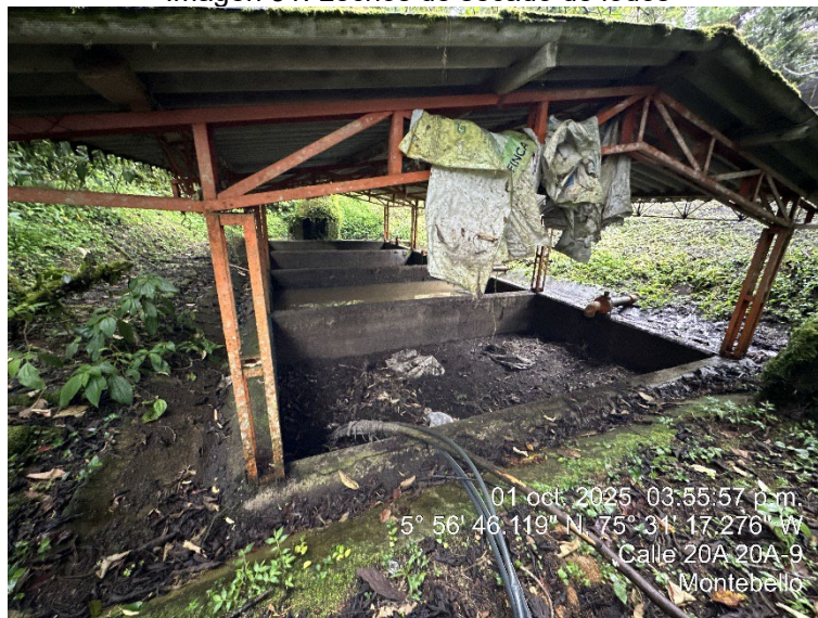
Imagen 31. Lechos de secado de lodos
