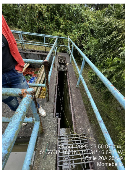
Imágenes 32 y 33 . Deterioro de plataformas de mantenimiento existentes sobre los sedimentadores y FAFA
