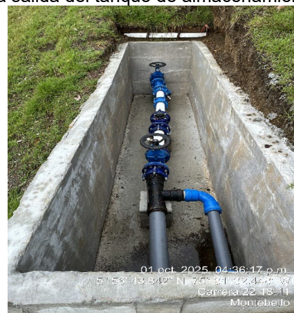
Imagen 21. Macromedidor presente a la salida del tanque de almacenamiento
