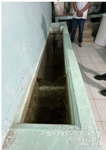
Imagen 14. Canal de acceso a la PTAP con vertedero triangular de pared delgada
