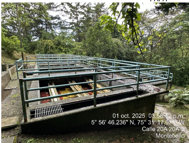
Imágenes 32 y 33 . Deterioro de plataformas de mantenimiento existentes sobre los sedimentadores y FAFA
