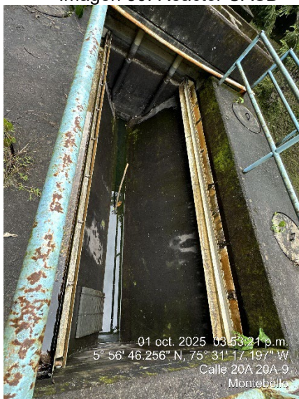
Imagen 30. Reactor UASB
