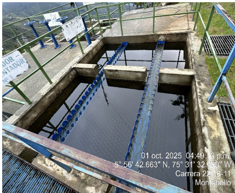
Imagen 15. Floculador/Sedimentador
