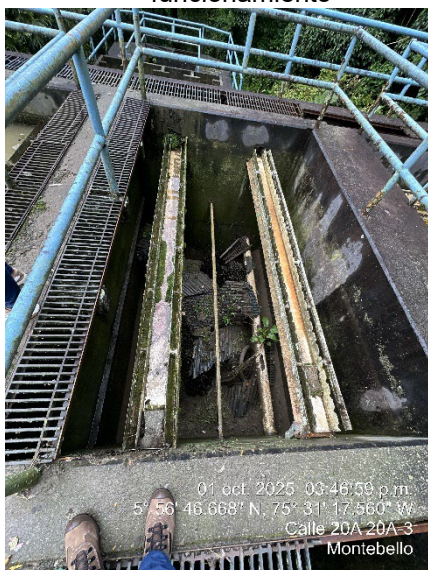
Imagen 28. Sedimentador sin funcionamiento
