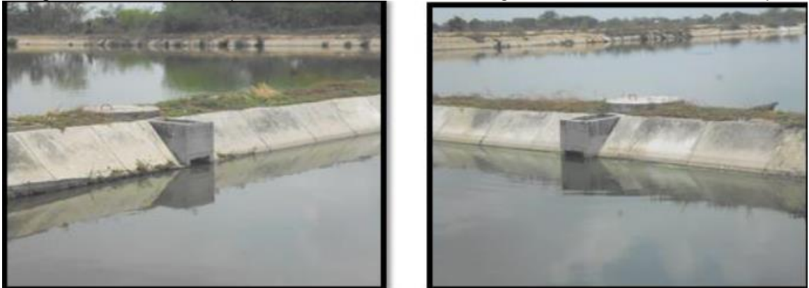
Imagen 63. Sección de Diques sistema de tratamiento de aguas residuales vía Puerto Mosquito
