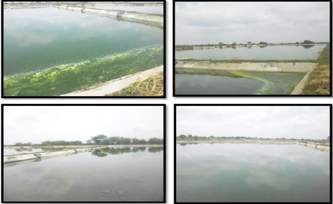
Imagen 62. Sección de Lagunas sistema de tratamiento de aguas residuales vía Puerto Mosquito
