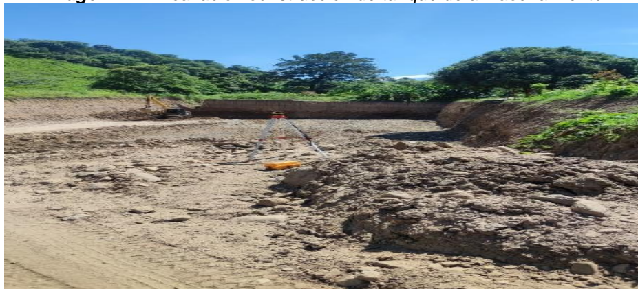
Imagen 24. Excavación construcción de tanque de almacenamiento
