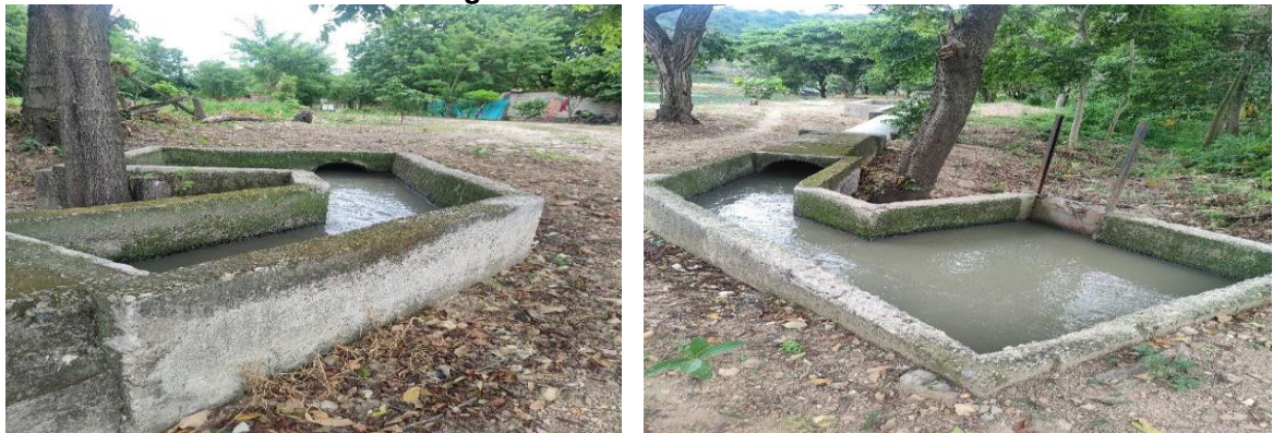
Imagen 53. Estructura de entrada
