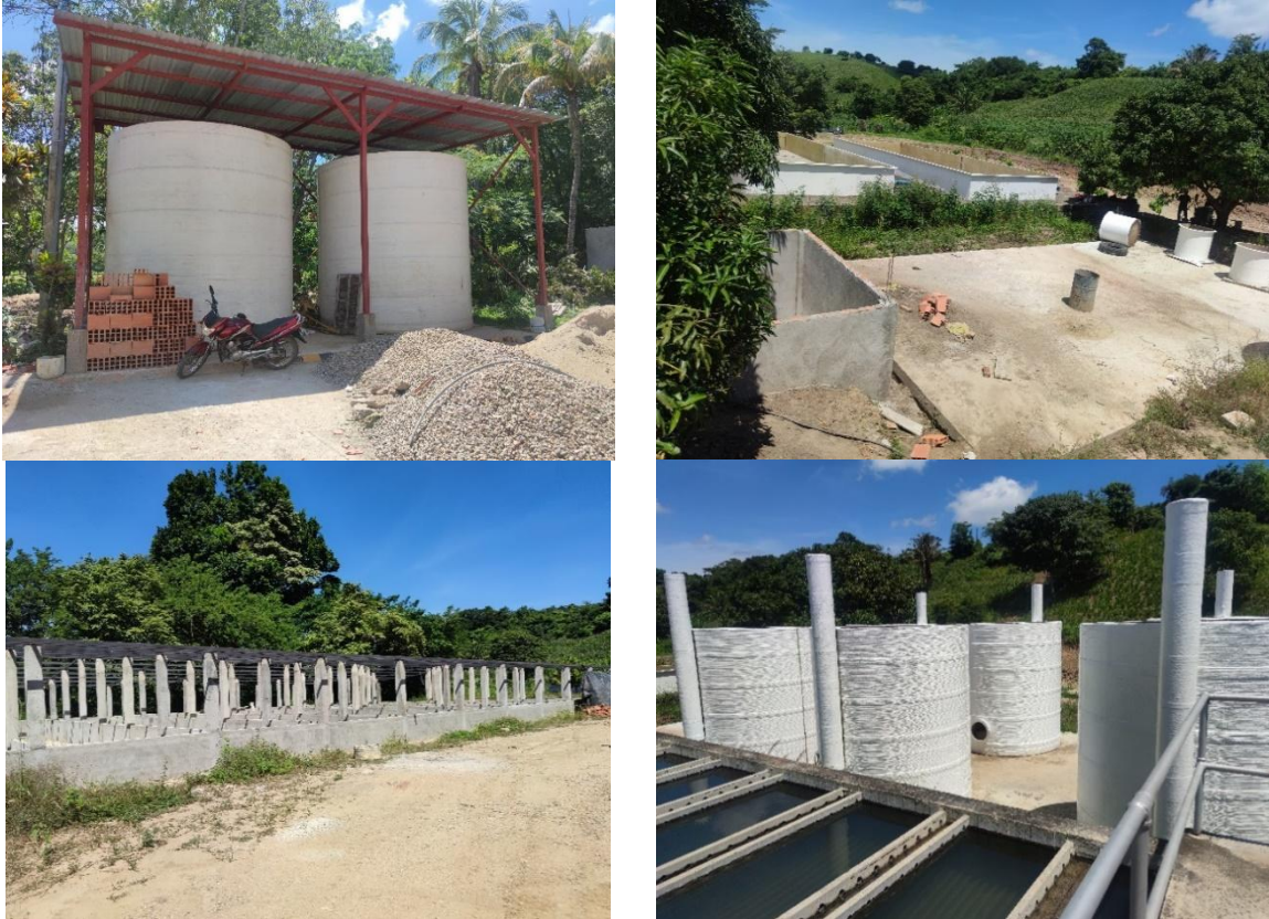
Imagen 23. Obras en ejecución PTAP
