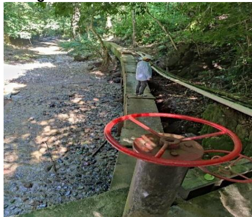
Imagen 13. Línea o canal de Aducción
