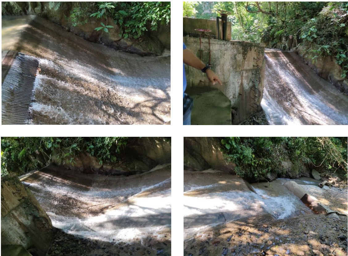
Imagen 12. Estructura de captación y bocatoma
