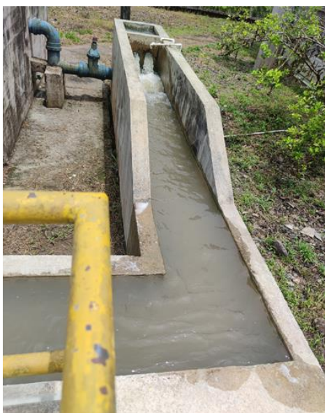
Vista general desarenador, Canal de mezcla rápida y Canaleta Parshall Fuente: Registro fotográfico de la visita SSPD, agosto de 2024.
