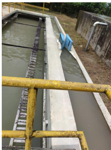
Vista general desarenador, Canal de mezcla rápida y Canaleta Parshall Fuente: Registro fotográfico de la visita SSPD, agosto de 2024.
