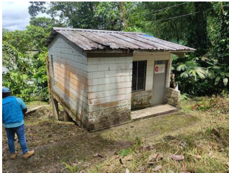
Imagen 8. Estación de Bombeo de Agua Cruda Empresa Eficiente de Servicios Públicos de Yuto S.A.S. E.S.P.
