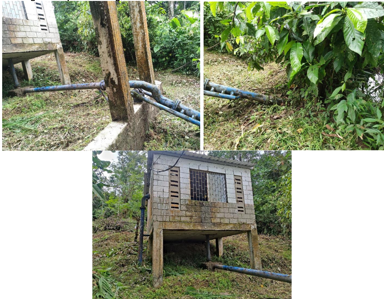
Caseta de Bombeo de Captación
