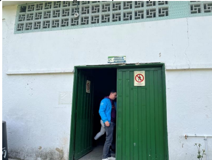
Imagen 23. Portón de ingreso a la planta de producción de Bokashi
