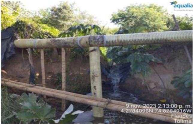
IMAGEN 7. Instalación de la tubería para rehabilitar laguna 2.
