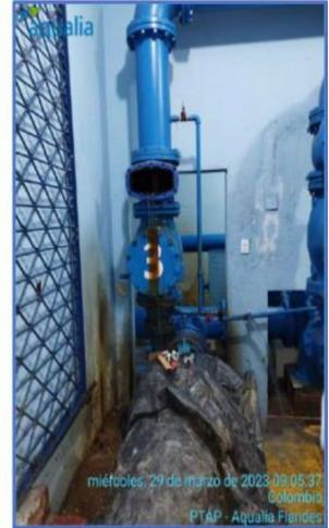
Mantenimiento correctivo de válvula de columna bomba #3 de la EBAT
