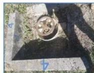
Estas válvulas de ingreso de agua cruda al sistema de la planta; ingresan en una tubería de 14", y al ingresar a los desarenadores se reduce a 10".
