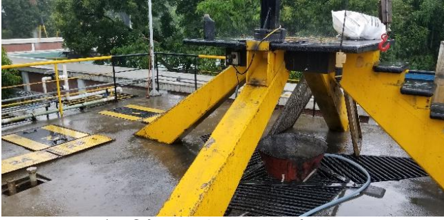
c) Cámara de mezcla rápida.
