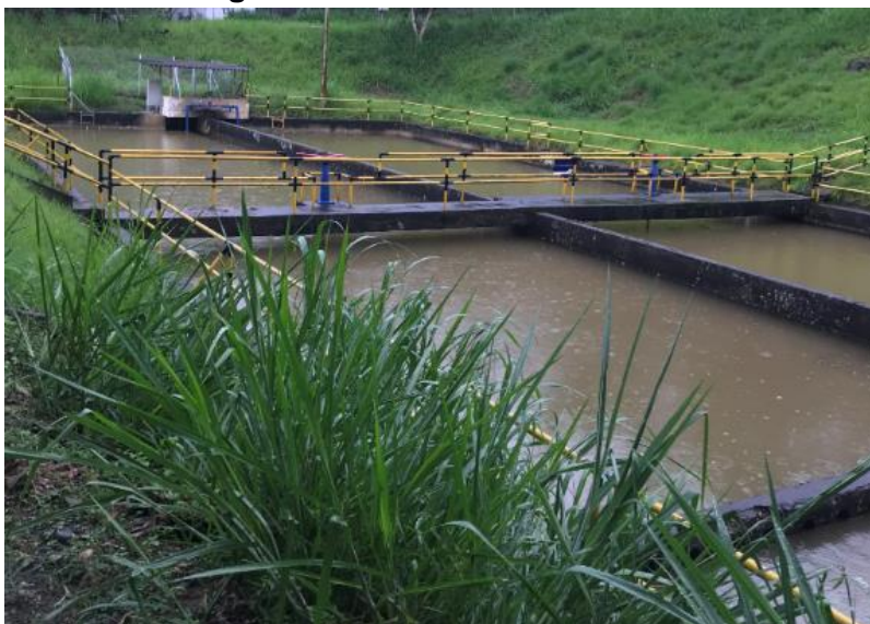
Sistema de desarenación Sistema Río Cali
