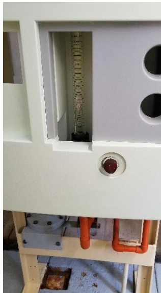
g) Dosificación de cloro gaseoso.
