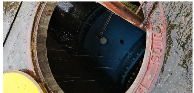
j) Macromedidor – Salida de la planta.
