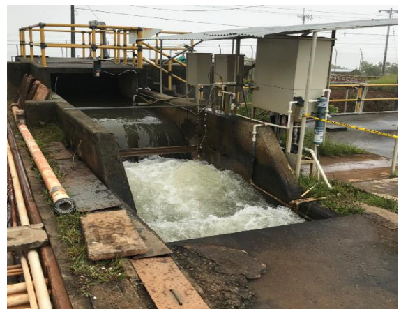
Resalto Hidráulico de entrada
