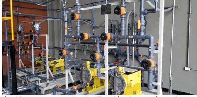
c) Nuevo sistema de dosificación de carbón activado. Fuente: Registro fotográfico SSPD – visita mayo de 2018
