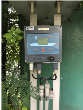
Imagen 59 Macromedidores a la entrada de la PTAR
