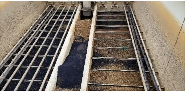
e) Lecho de los filtros.
