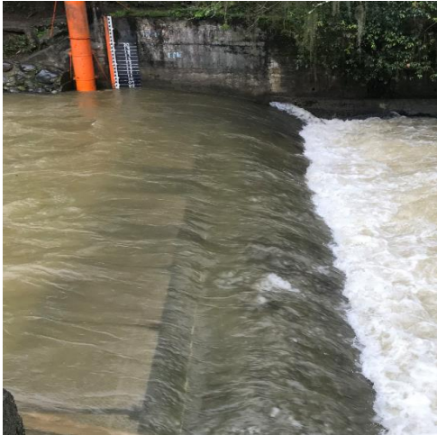
Bocatoma de Fondo
