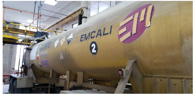
f) Tanque de cloro gaseoso.
