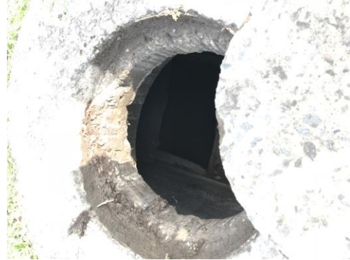
Cra. 15 con calle 73, conectada al Canal Oriental.
