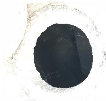
Cra. 15 con calle 23 – Aguas lluvias
