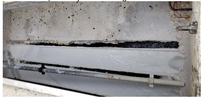
h) Aplicación de cal.
