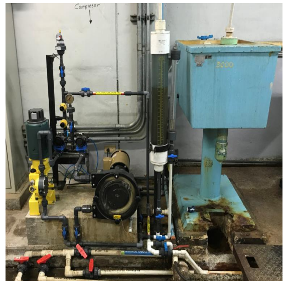
Dosificación del Coagulante.
