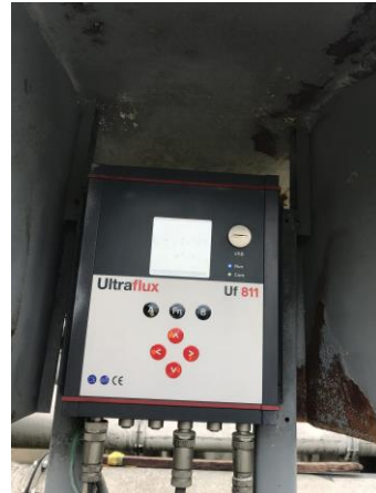
Imagen 59 Macromedidores a la entrada de la PTAR
