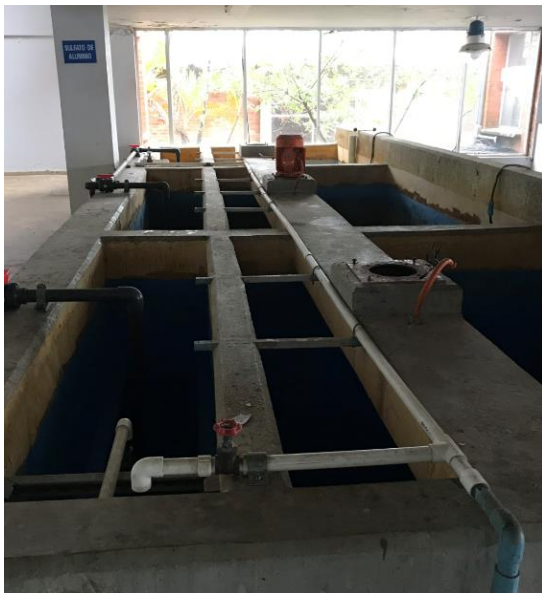
Almacenamiento del Coagulante
