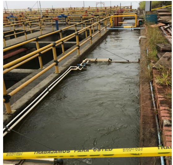
Canal de Aquietamiento
