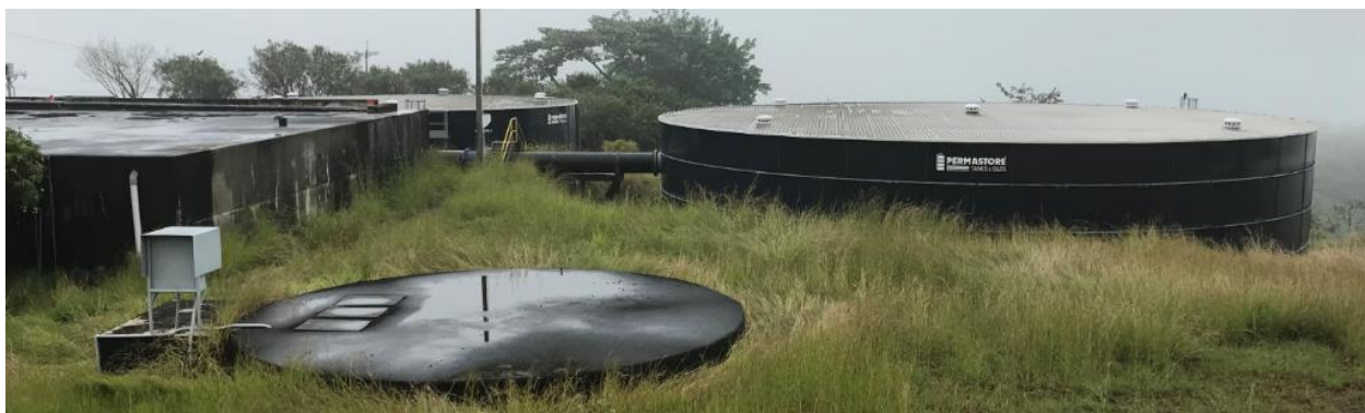
Almacenamiento PTAP La Reforma
