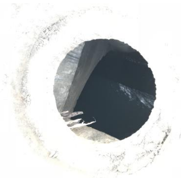
Cra. 15 con calle 23 – Aguas domesticas
