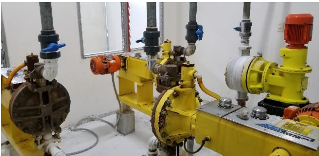
i) Dosificación de cal.
