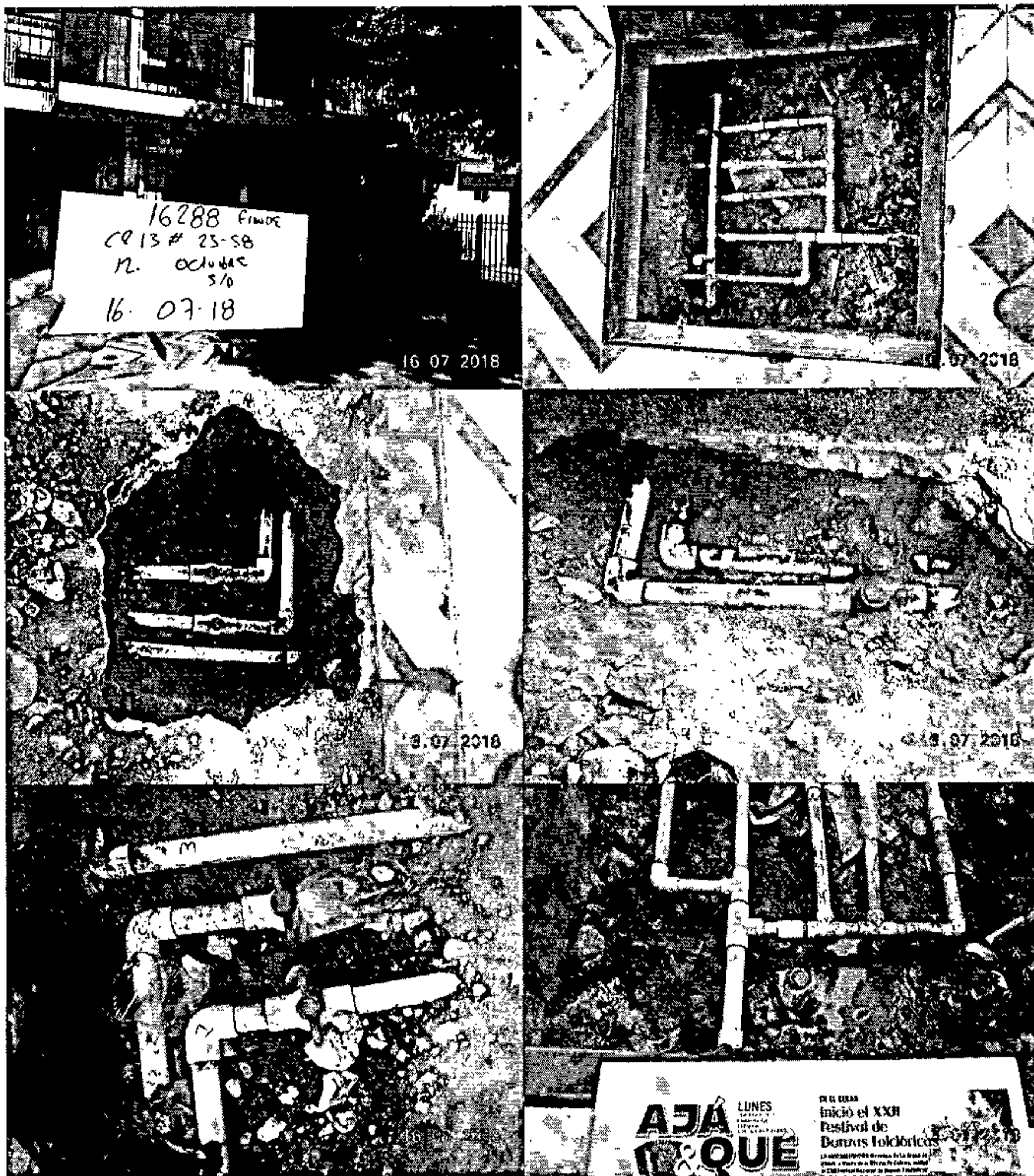
Figura No. 8 Fraude – Código 16288 - Taponamiento de anomalia
